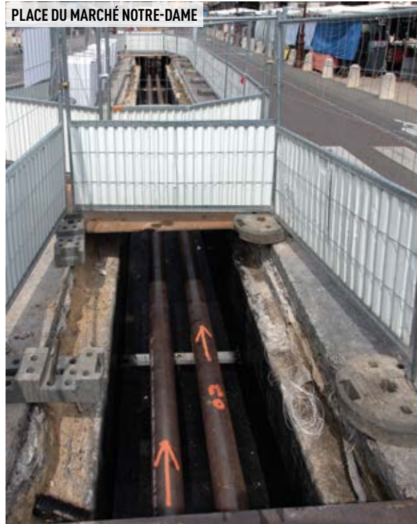
Renouvellement du réseau chaleur.
