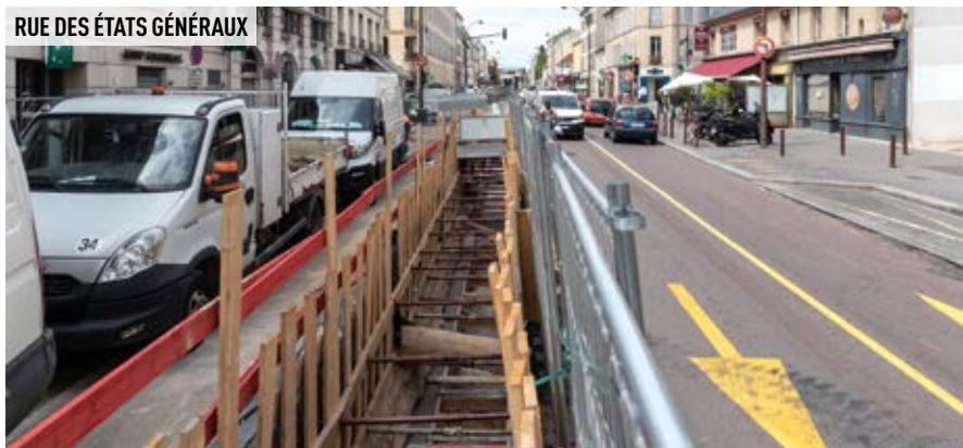
Travaux sur les réseaux.
