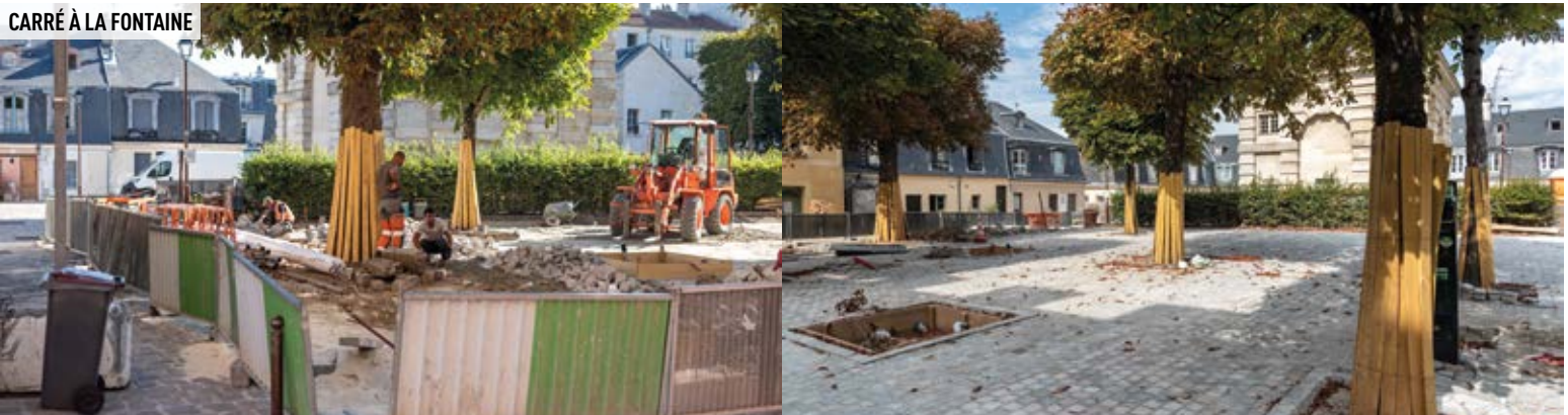
Travaux de rénovation.
