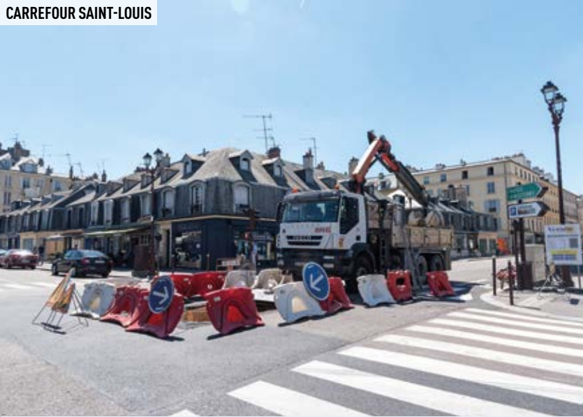
Renouvellement du réseau chaleur.
