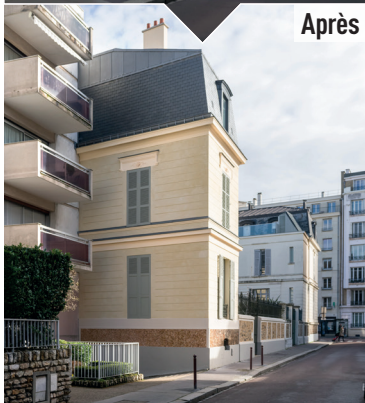
33, rue de Beauvau : Prix Maçonnerie - Trompe l'œil.
