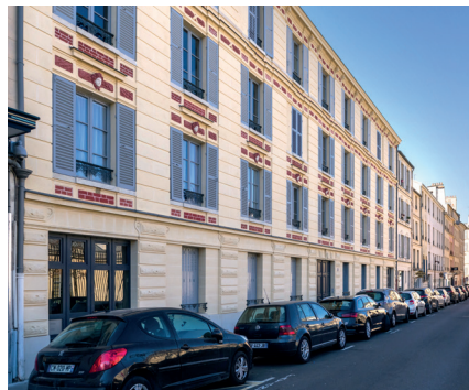
14, rue Richaud : Prix Maçonnerie.
