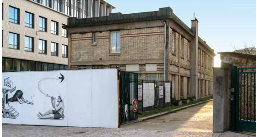
Le bâtiment SNCF Poincaré en cours de restauration.
