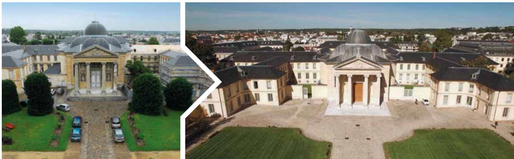
La chapelle du lycée Hoche La réhabilitation intérieure et extérieure de la chapelle du lycée Hoche a permis la restitution à l'identique de ce joyau de l'architecture religieuse.
