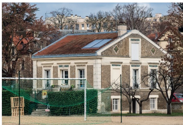
Panneaux solaires sur la maison de gardiennage du square Blaise Pascal.
