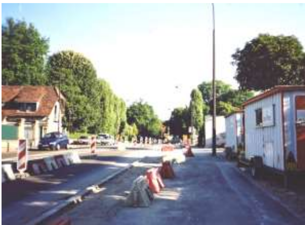
Travaux d'aménagement routier Pershing à l'été 2001
